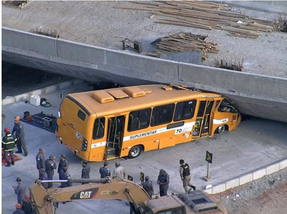
FIGURA 5 - Micro-ônibus atingido pela queda do viaduto Guararapes.
