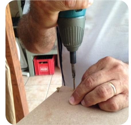
Fixação entre as placas utilizando parafusadeira e parafuso Philips nº2.
