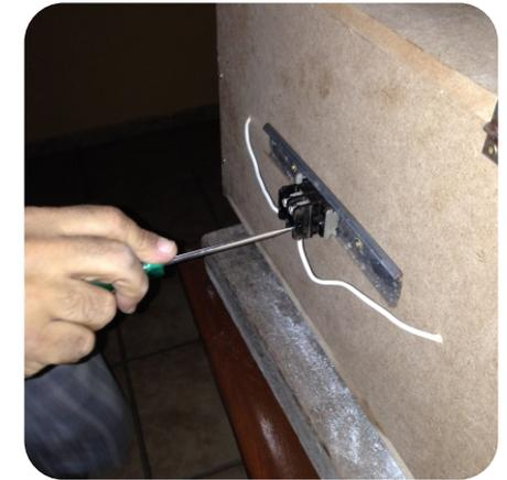
Instalação dos cabos de alimentação da lâmpada, com chave de fenda 1/4" ou Philips nº2.
