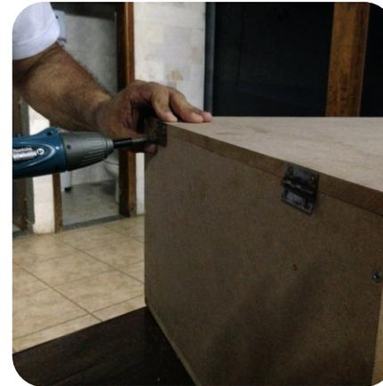
Fixação da dobradiça 2"x3/4" com parafusadeira ponta Philips nº2.
